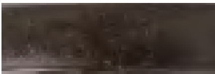
ÓXIDO | OXIDE | OXIDE | OXIDO
